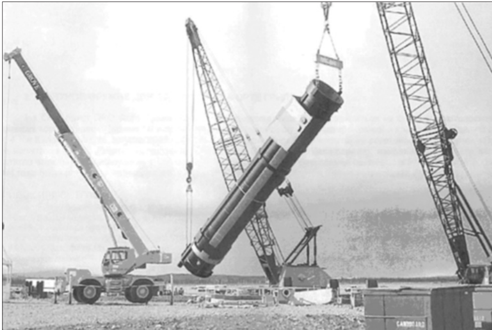
Установка элементов оборудования шахтной пусковой установки в позиционном районе Форт-Грили (штат Аляска)
